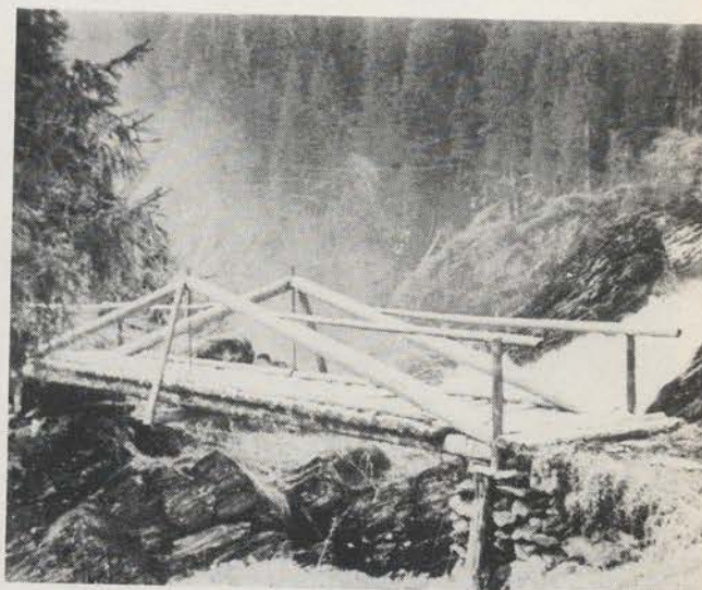
Kvernbrua. Bru over Kverna ved Oterhullet 1939.
