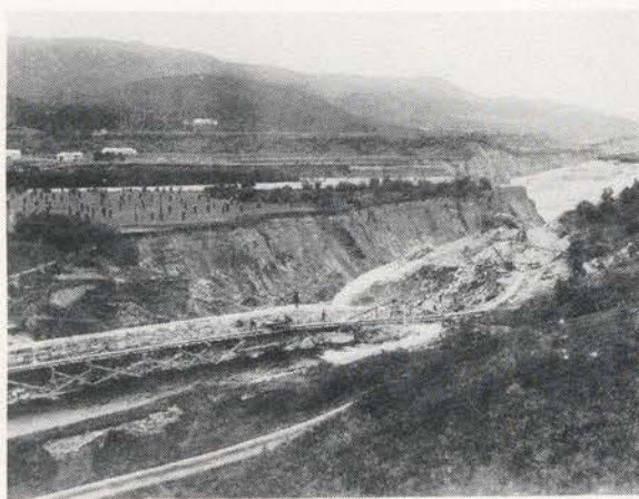
Bygging av støttemur mot Malså ved Volla-fossen.
