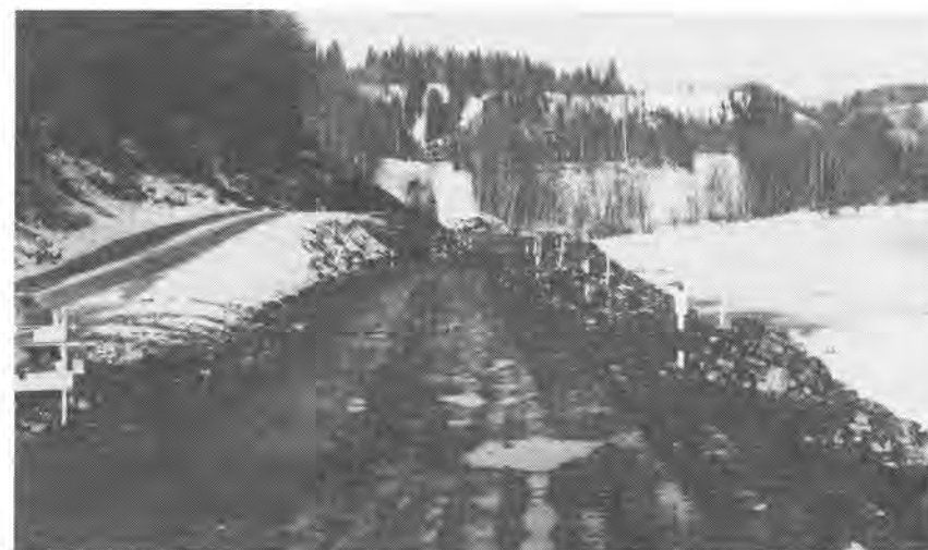
Veien under utbedring.
