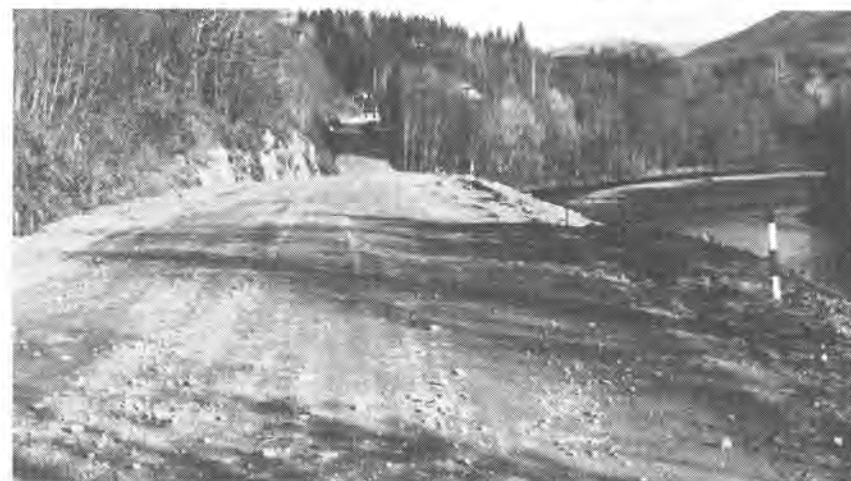
På samme sted etter utbedringen.
