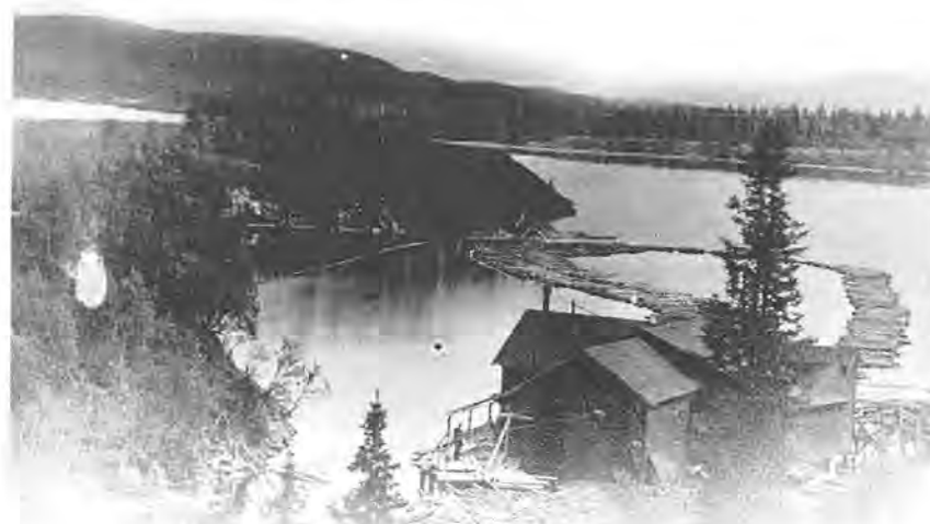
Taubanestasjonen ved Esingen
